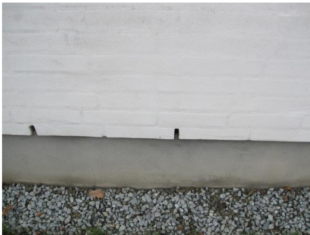
Her ses åbne studsfiger som man bør overveje at montere studsfigeventiler.
