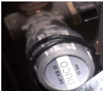
Billede af sikringsventil
