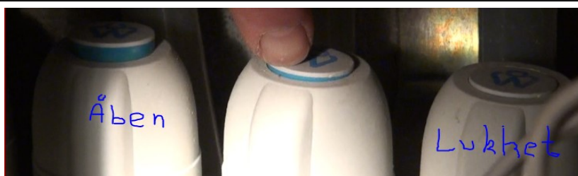
Billede 4 – ventiler/ termomotorer
