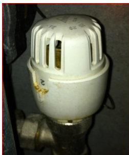
Billede 3 – reguleringsenhed. Til styring af gulvtemperatur
