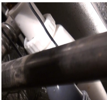
Billede af vandlås – hvor der skal fyldes vand på
