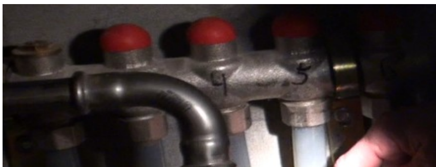
Billede 6 – gulvstrengssystem
