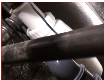
Billede af vandlås – hvor der skal fyldes vand på
